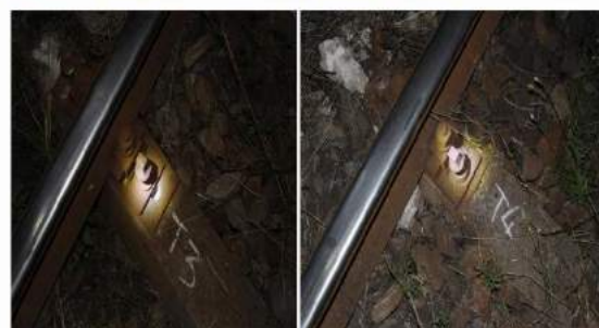
foto 18-21: traversa T 1 - T 4 pe firul exterior al curbei
