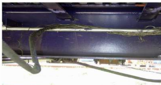
Foto 3: cablu oțelit rupt
