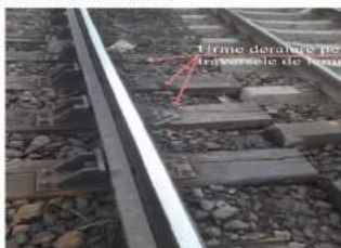
Foto nr.3 – urme de lovire a traverselor de lemn de către roțile deraiate
