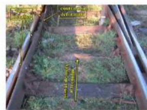
foto nr.7 – contrașină deformată
