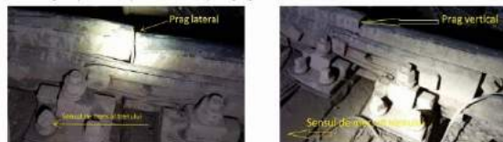
Foto nr.12-prag lateral (vedere dinspre exteriorul căii) Foto nr.13-prag vertical
