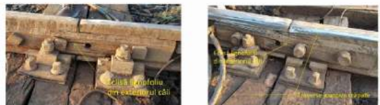
Foto nr.14 eclisa de lignofoliu din exteriorul căii Foto nr.15 eclisa de lignofoliu din interiorul căii
