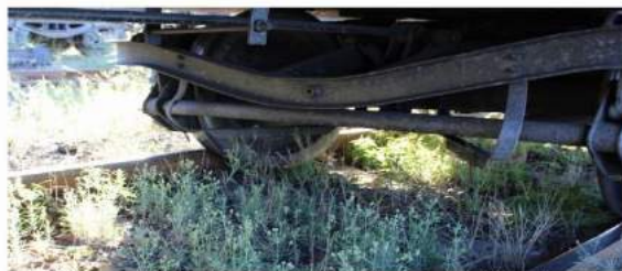
foto 4: poziția roții nr.5 a vagonului aflat al 40-lea în compunerea trenului, după derajere
