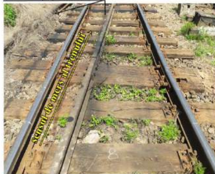
Figura nr.8 -Starea tehnică a suprastructurii căii
