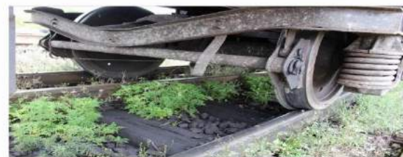
foto 6: poziția boghiului I al vagonului aflat al 25-lea în componența trenului, după deraiere
