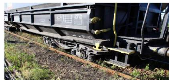
foto 2: poziția vagonului aflat al 39-lea în compunerea trenului, după derajere
