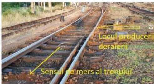
Foto nr.2 - parcurusul trenului - schimbătorul nr.21A atacat pe la călci, schimbătorul nr.25A atacat pe la vârf, ambele pe direcția abaterii
