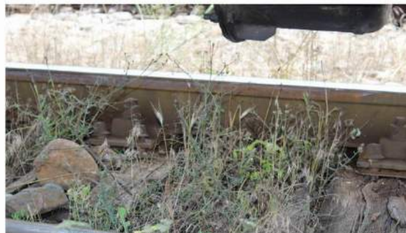
foto 12: urme de frecare specifice căderii roții în interiorul căii (zona punctului 0)
