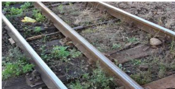
foto 13 : dispozitive de ajustare a ecartamentului
