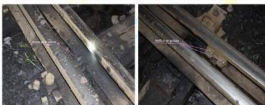
foto 5,6 - lovituri ale materialului metalic de către roțile deranate
