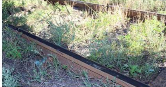
foto 6 - starea prismei de piatră spartă pe zona producerii accidentului
