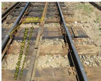
Figura nr.4 – urme identificate pe șine
