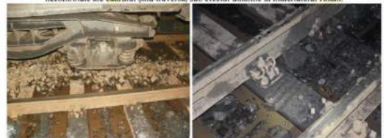
foto 9, 10, 11, 12 - starea prismei de piatră spartă pe zona producerea accidentului
