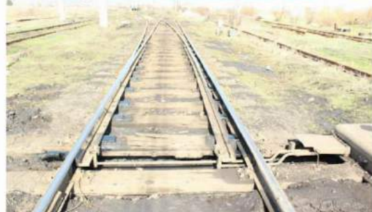
foto 3 - schimbătorul de cale nr. 24 după producerea deraierei
