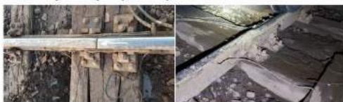
Foto nr.16 – prisma de piatră spartă colmatată(joantă noroioasă)
