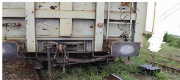
foto 1: poziția boghiului I al vagonului aflat al 16-lea în componența trenului, după deraiere
