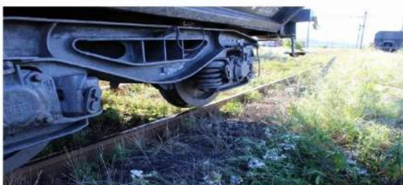
foto 5: poziția roții nr.8 a vagonului aflat al 40-lea în din compunerea trenului, după derajere
