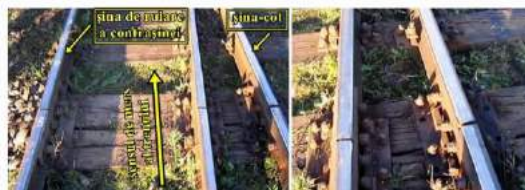
foto nr.8 - direcția „abateră” traversele din zona joantei de vârf a inimii
