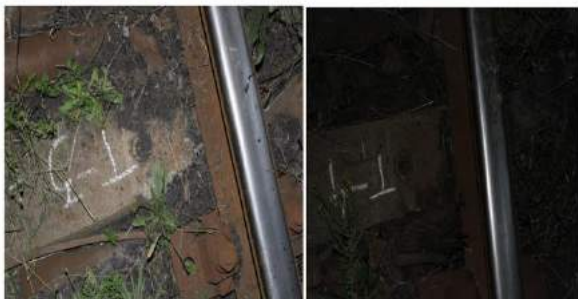
foto 14-17: traversa T 1 – T 4 pe firul exterior al curbei
