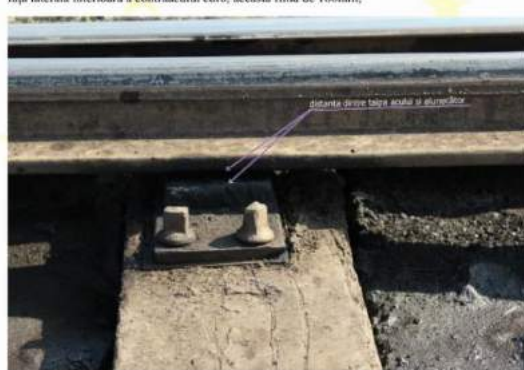
foto 8 - poziția acului curb față de alunecători
