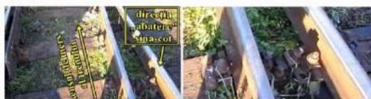
foto nr.10 - direcția „abateră” - șina-cot și traversa nr.4
