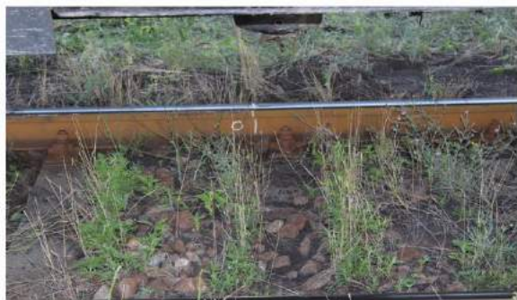
foto 27. Urma buzelor bandajelor rupte dreapta la părăsirea ciupercei șinei în zona punctului 0
