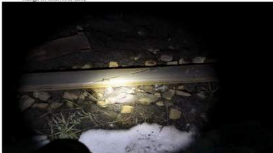
Foto 16 - urmele de escaladare a roților pe ciuperca șinei din dreapta a diagonalei 18-24
